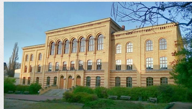
IGS Halle Am Steintor, Adam-Kuckhoff-Straße 37
